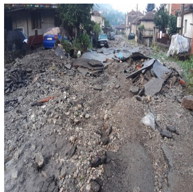
26.VI – гр. Котел след пороя ( БГНЕС )
