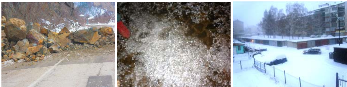
9.1 Обрушена скала на път през Искърското дефиле
